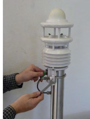
Abbildung 8: Verbinden des Kabels mit der Wetterstation
