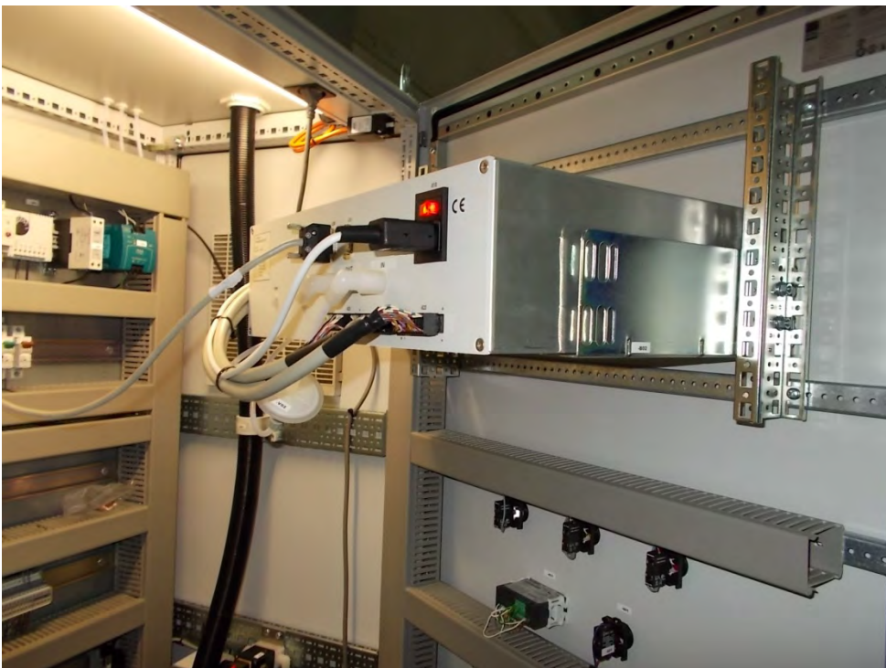
Abbildung 3: Einbausituation Analysator
